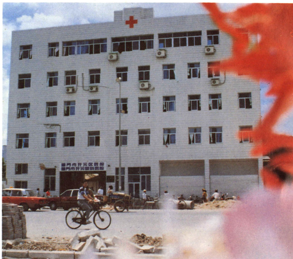
厦门市开元区医院和厦门市开元眼科医院
