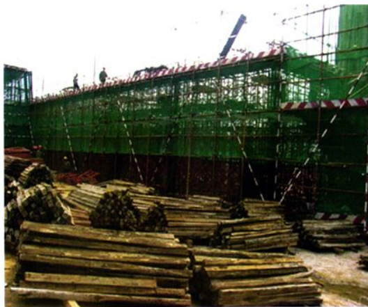
◎ 新校区建设工地
