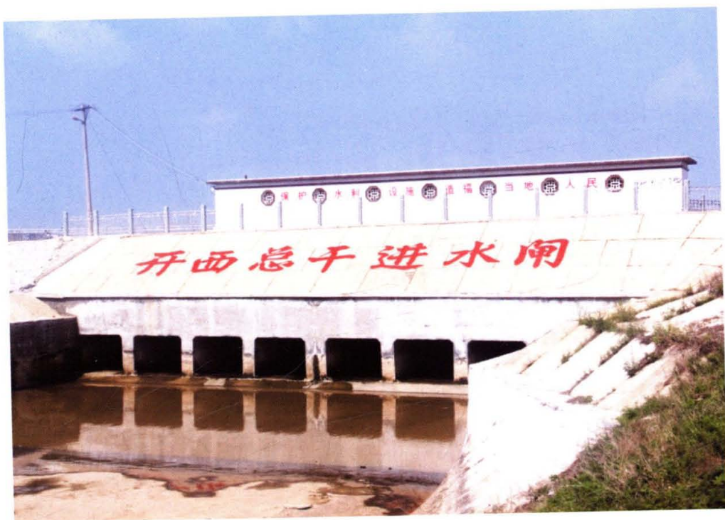
开西灌区总干进水闸取水口
