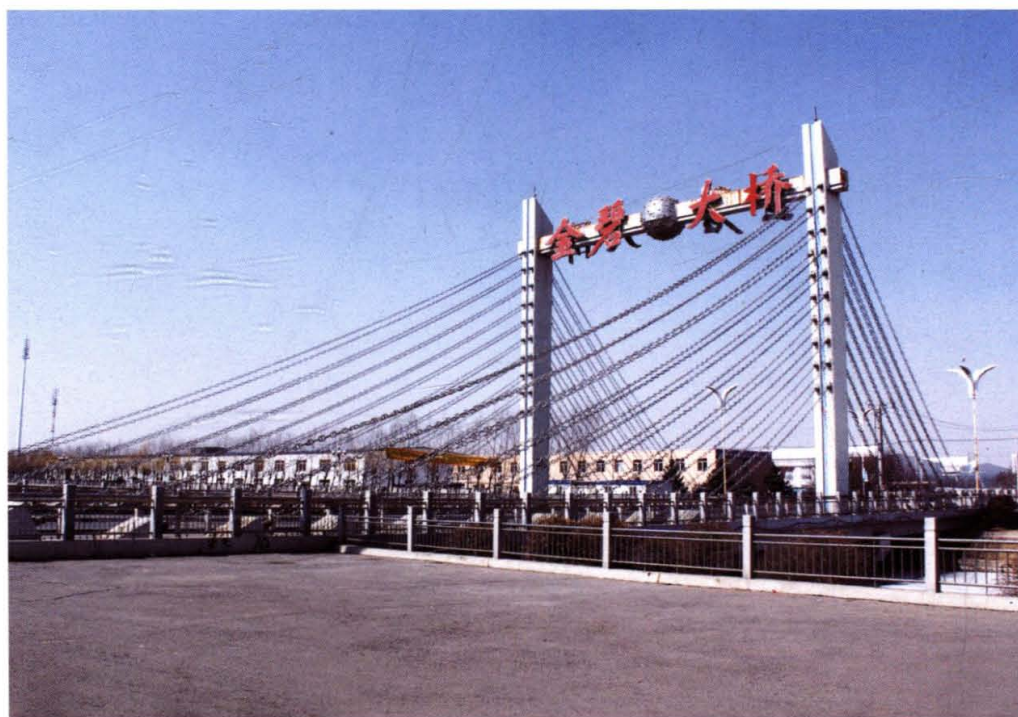
小清河金碧大桥
