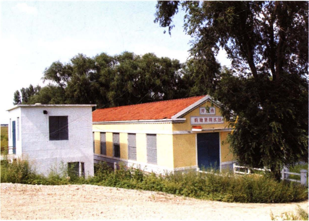
前施堡排水站
