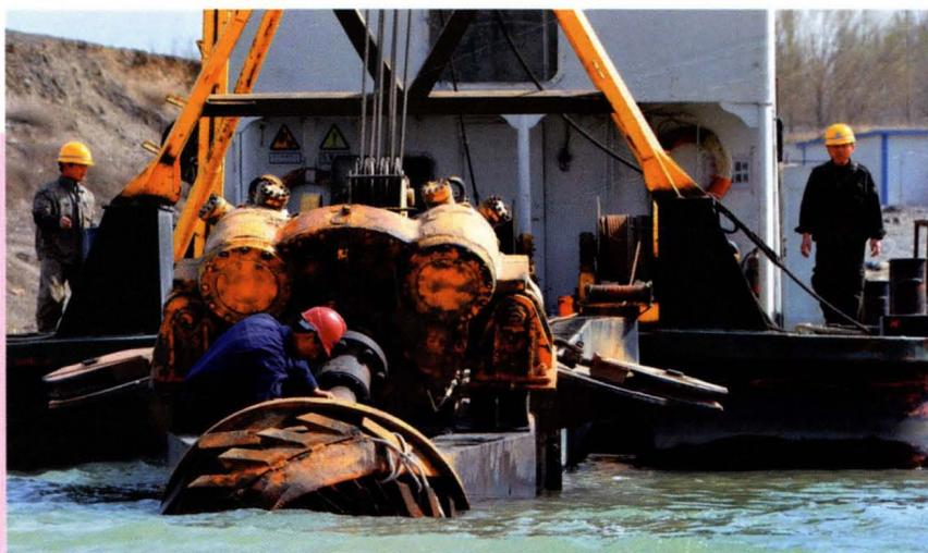
2011年4月19日,由乌鲁木齐市投资1.88亿元,从2009年开始进行的乌拉泊水库清淤工程全面复工。工程完成后将为乌拉泊水库清淤120万立方米,新增库容120万立方米,进一步提高水库输水泄洪功能。姚彤摄
