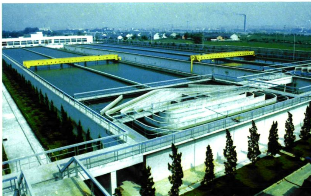
城市供水关系千家万户。长期以来,市建行努力服务于合肥市供水设施的改造与完善。图为市建行经办拨款的合肥三水厂净化沉淀池。
