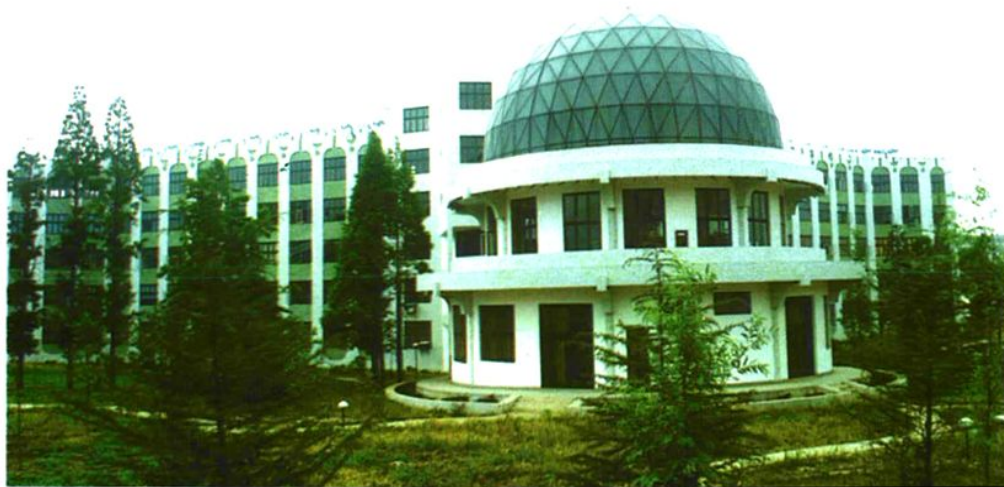
安徽农业大学是市建行经办拨款的重点科教项目。图为该校现代林木系教学楼外景。
