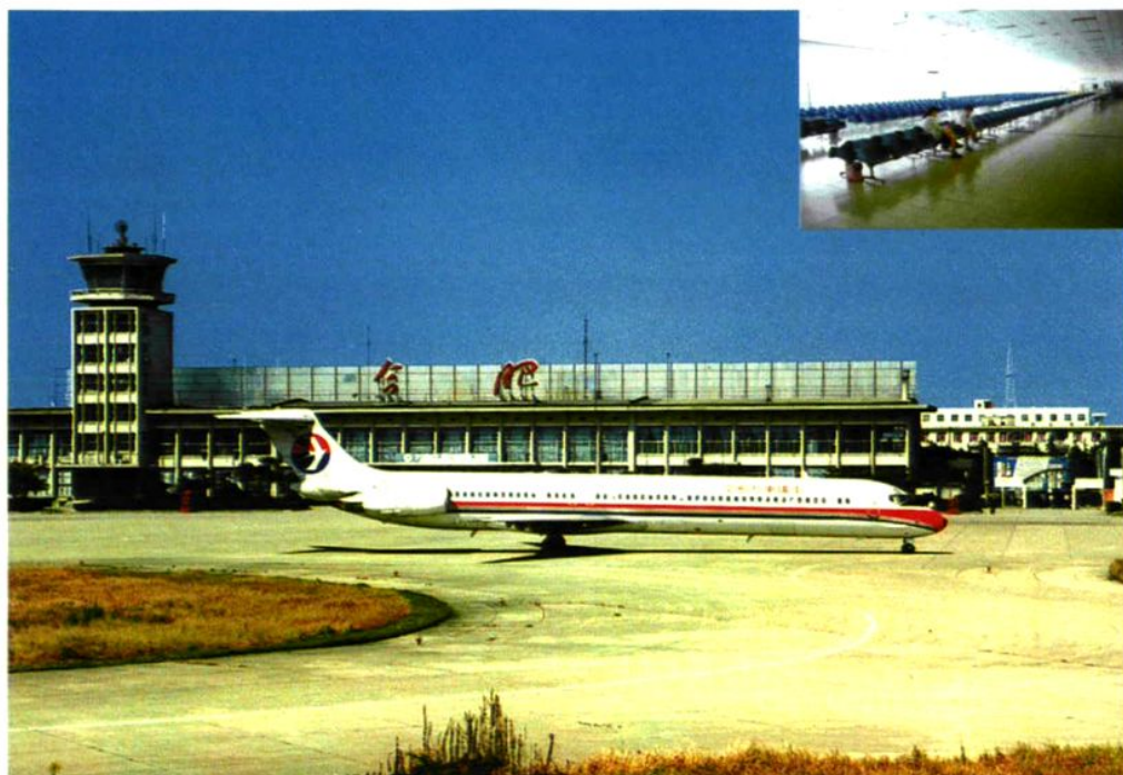
交通运输行业是市建行的主要投资方向之一。图为该行经办拨款的合肥骆岗机场。该机场是合肥地区的主要空港。
