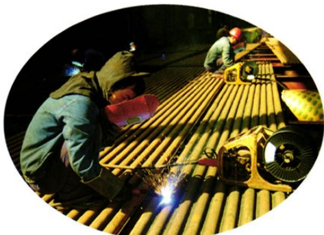
东气公司生产车间
