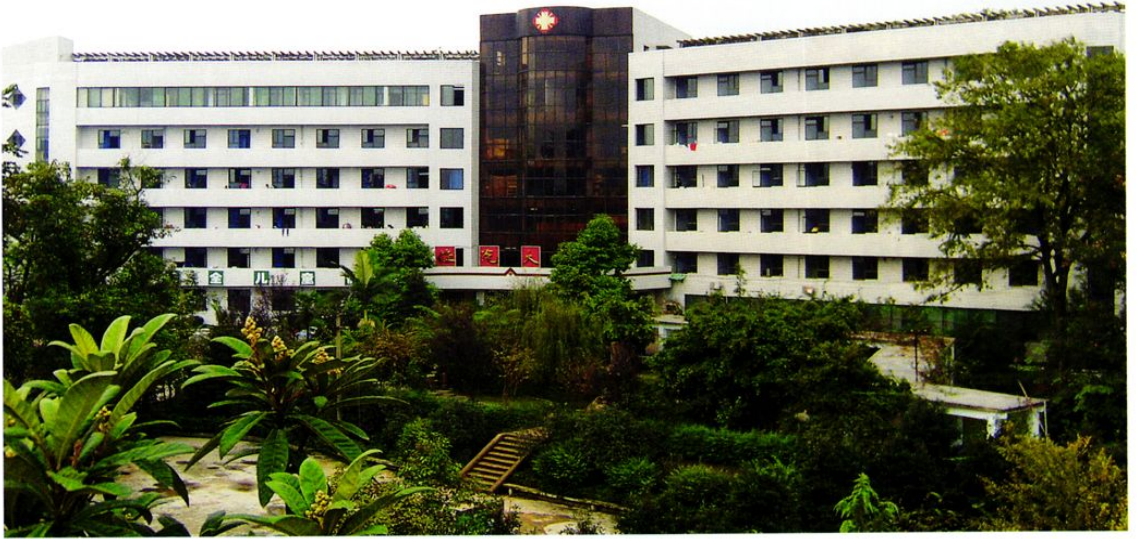
县人民医院住院大楼
