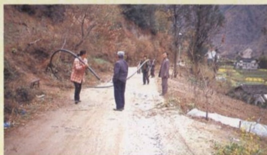
架设输水管道
