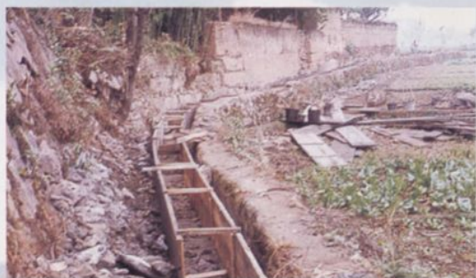
建设中的三面光堰渠
