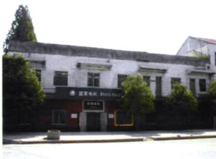
2002年5月改造后的钱场供电营业所办公楼
