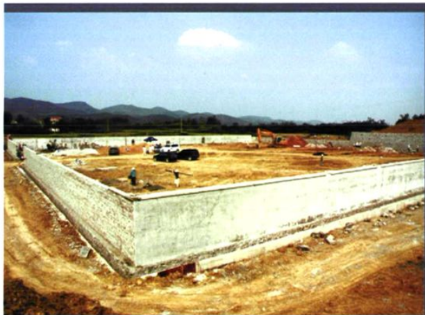
2007年7月15日，110千伏屈场输变电工程破土动工
