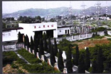
1979年4月，110千伏京山变电站（旧址）建成投运
