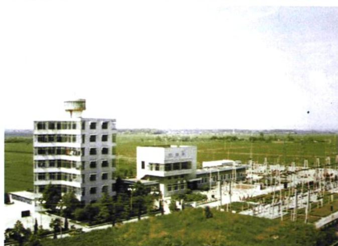
1991年2月升压后的110千伏永隆变电站全貌
