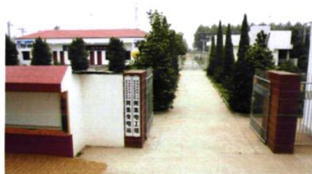
1993年3月，35千伏何集变电站建成投运
