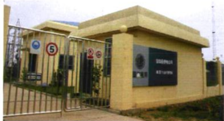
2005年8月，35千伏城东变电站建成投运
