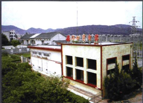
1982年6月，35千伏雁门口变电站建成投运
