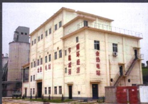
2007年12月兴建，2008年8月并网于马家塆变电站的永兴水泥厂余热发电站
