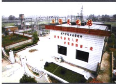
1983年9月，35千伏三阳变电站建成投运
