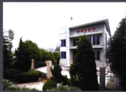
1984年12月，35千伏坪坝变电站建成投运
