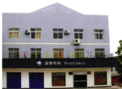
2007年12月建成的永兴供电营业所营业厅
