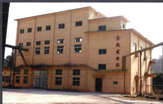
2007年9月建成，同月并网于钱场变电站运行的京兰水泥厂余热发电站
