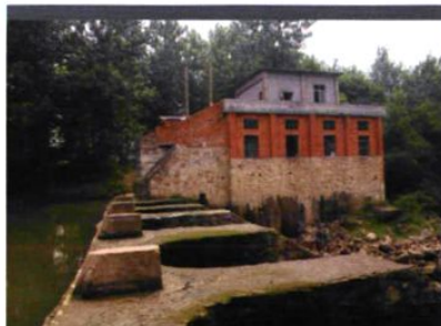
2004年8月投运，同月与永兴变电站并网运行的五福水电站
