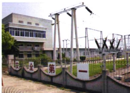
1991年2月，110千伏永隆变电站控制室建成投运
