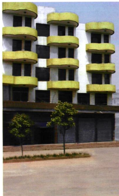
1991年2月，建成的永隆供电营业所办公大楼
