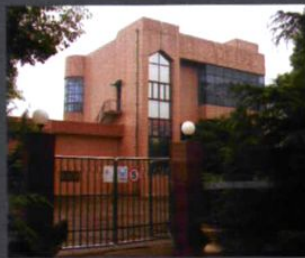
1998年8月投运的110千伏宋河变电站控制大楼
