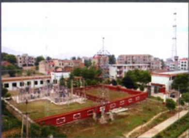
1979年7月，35千伏孙桥变电站建成投运， 1994年9月搬迁重建的孙桥变电站
