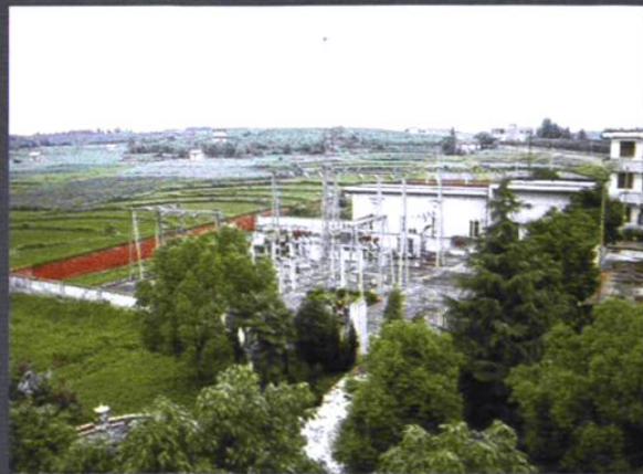
1979年4月，35千伏石龙变电站建成投运
