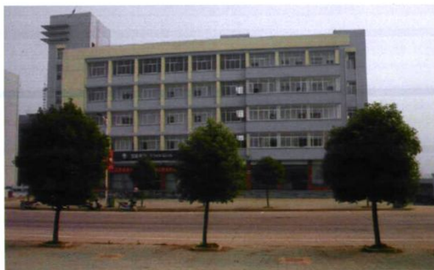
2007年5月18日竣工落成的屈家岭供电营业所
