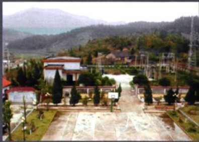
1988年9月，35千伏厂河变电站建成 投运，2002年更名为绿林变电站
