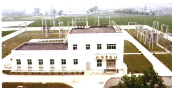
2001年11月，搬迁新建的110千伏钱场变电站
