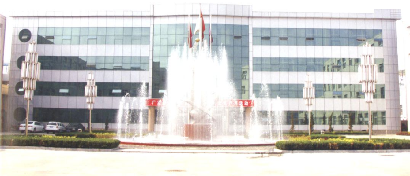
苏村煤矿办公区外景
