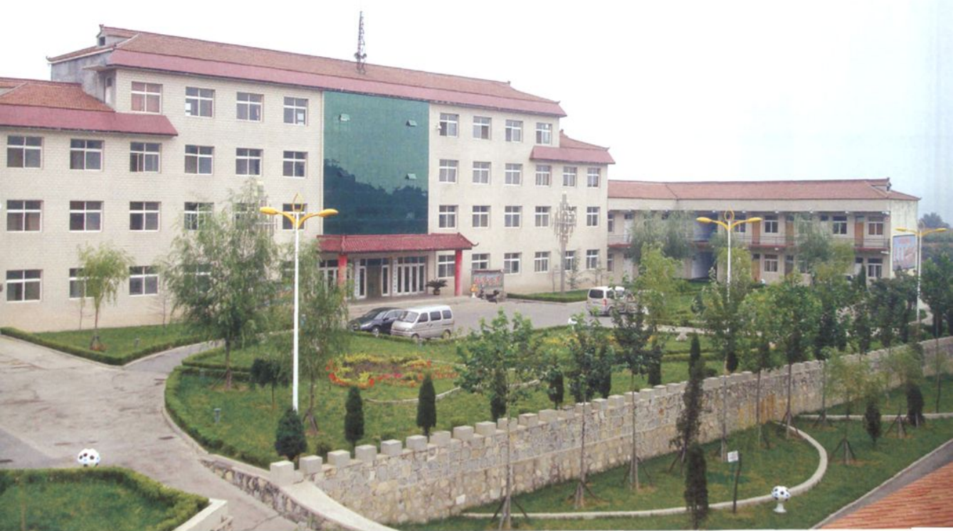
关岭山煤矿办公大楼
