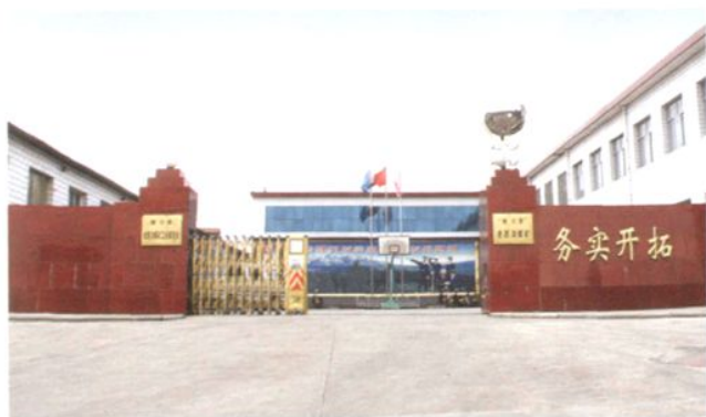
老西沟煤矿办公区外景
