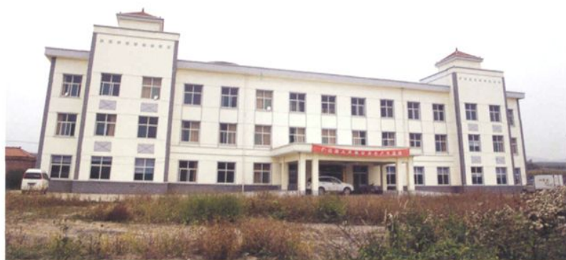
新沙河煤业办公大楼
