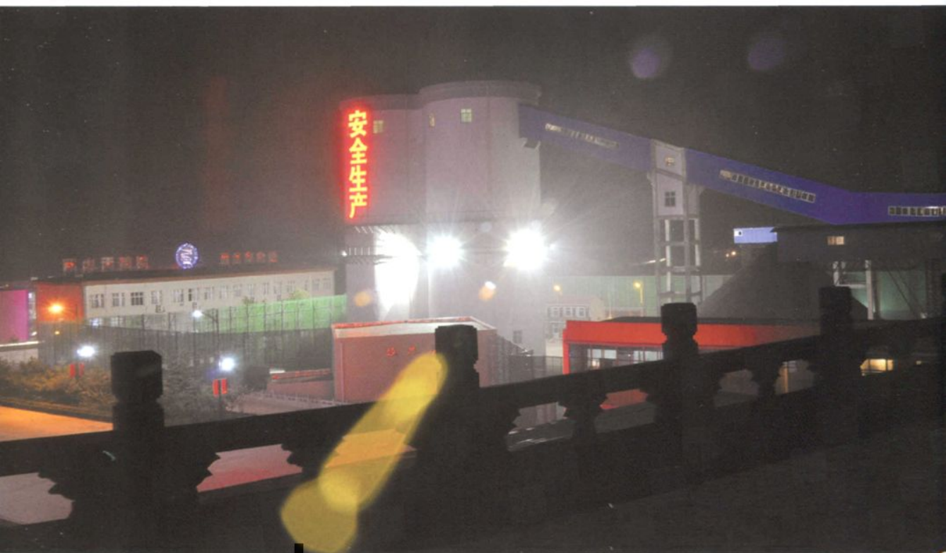
苏村煤矿矿区夜景
