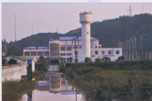
■ 丹郢区域第一座 220 千伏武当山变电站
