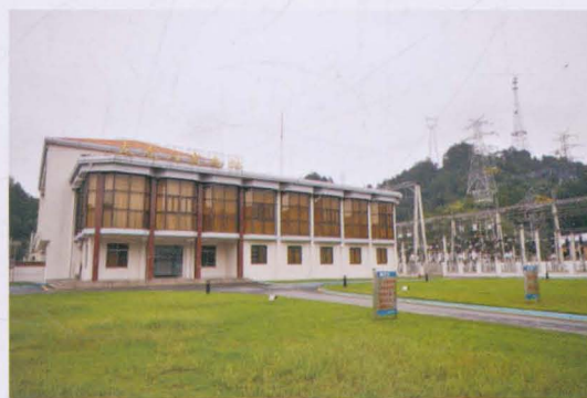
■ 十堰区域第一座 220 千伏龙虎沟变电站
