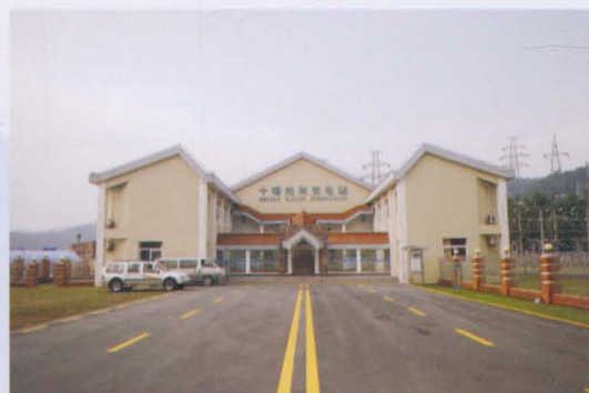
■ 220 千伏柏林变电站
