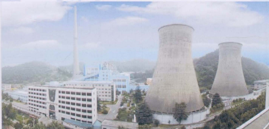
■ 东风汽车公司热电厂外景
