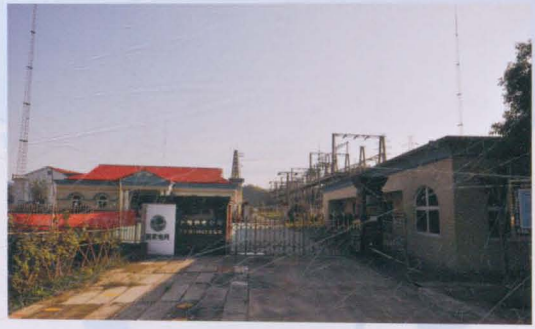
■ 110千伏丁家营变电站
