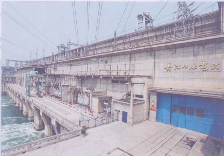
■ 丹江口水力发电厂外景
