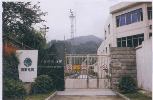
■ 十堰供电局所辖第一座城区110千伏葫岭变电站
