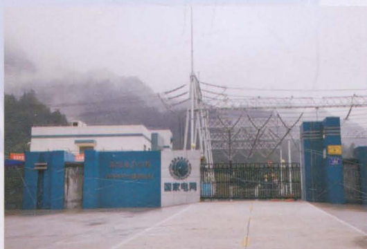
■ 十堰区域第一座 500 千伏变电站
