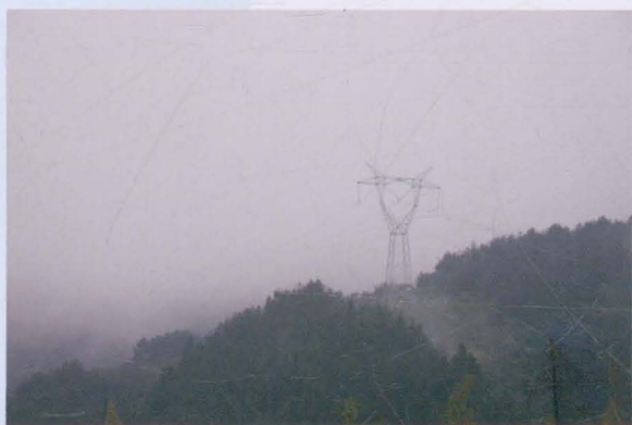
■ 500 千伏大川输电线路
