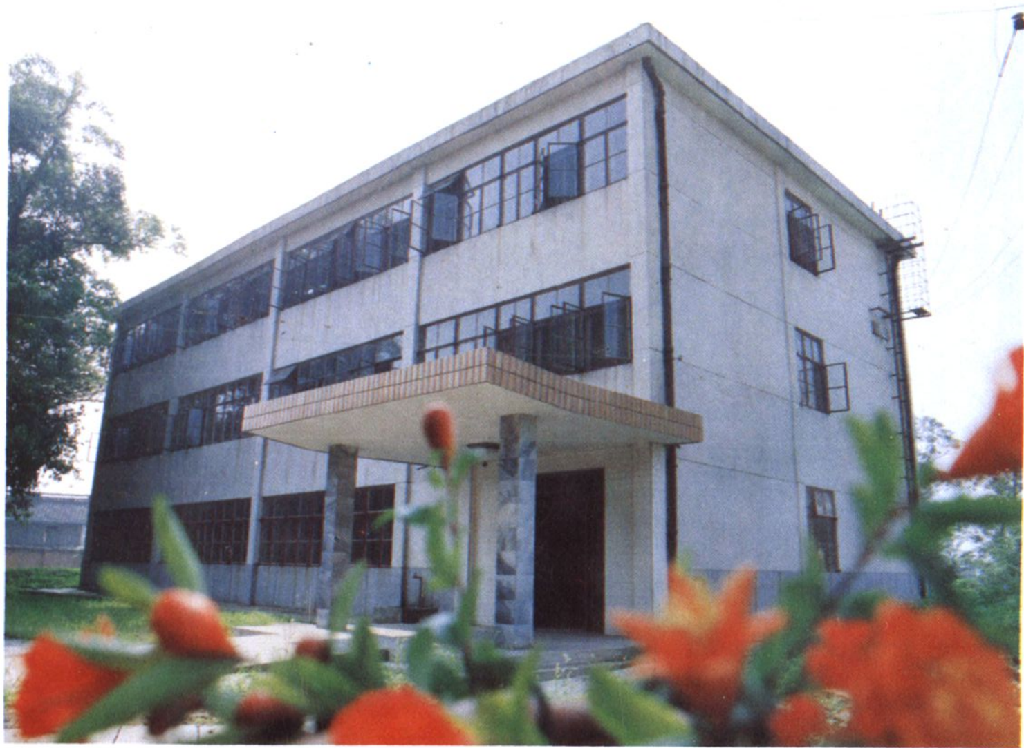
成都药械厂诊断液车间
