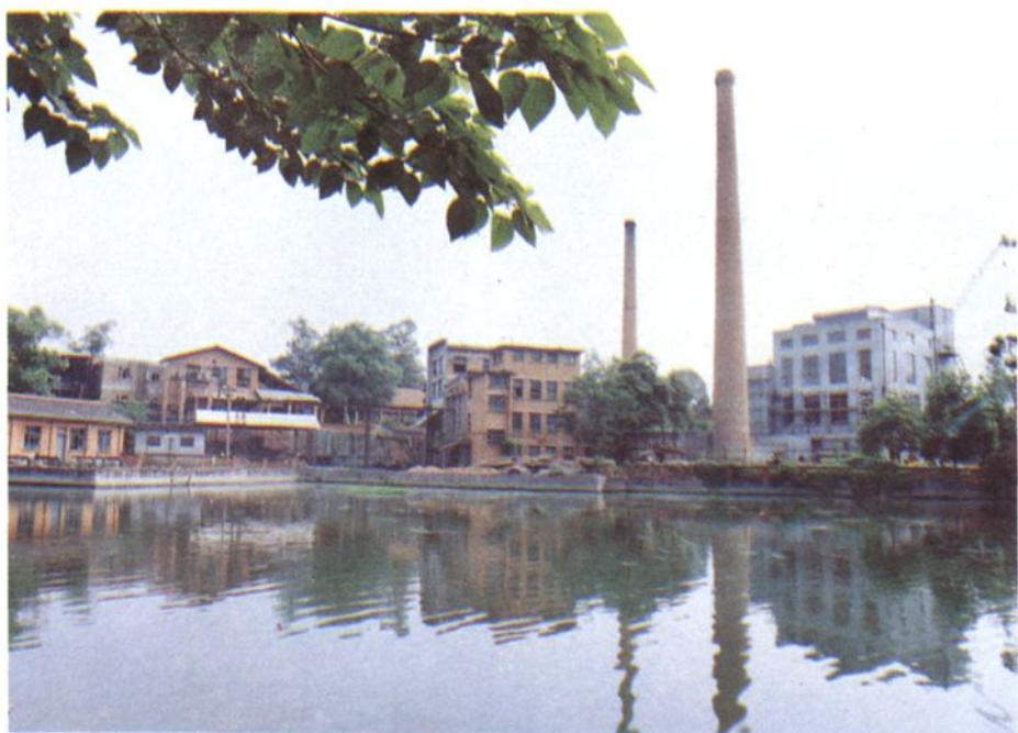
锅炉房及循环水池
