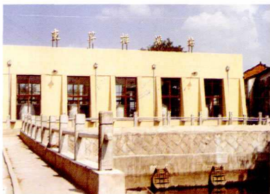
16. 洛舍东昇排涝站
