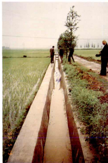
11. 三合杨坟三面光渠道
