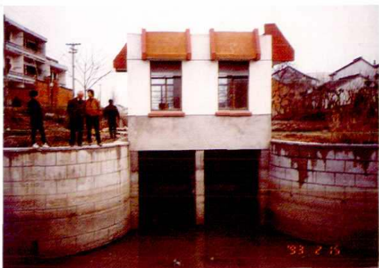
17. 钟管唐家墩泵站
