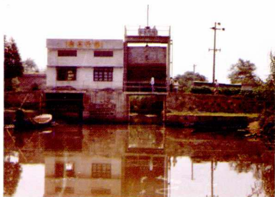
18. 千山俞家圩贯流泵站
