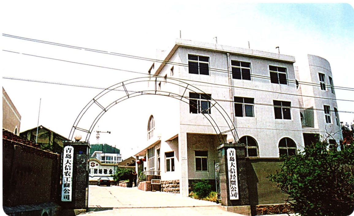
青島大信農工商公司、青島大信實業有限公司辦公樓（1998—2006年）
