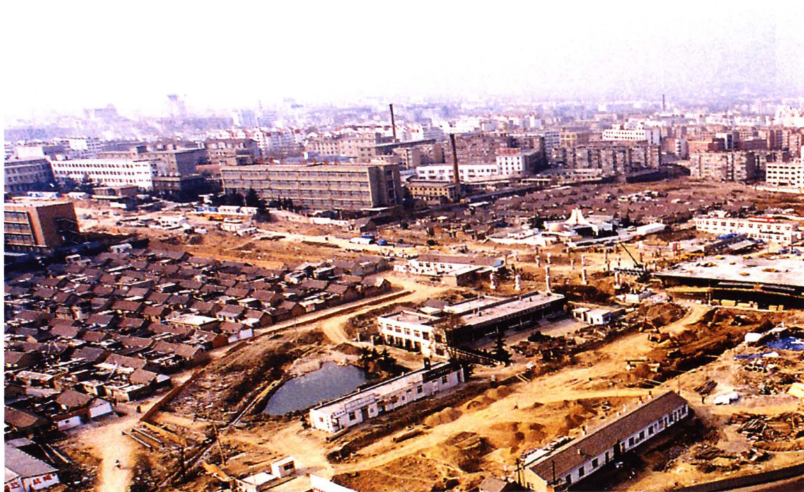
建设中的澳柯玛立交桥（1999年摄）
