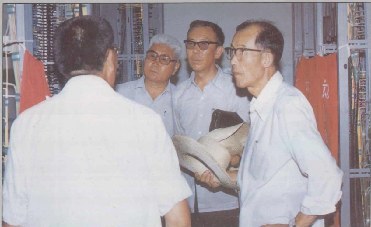
内蒙古电管局副局长丁圻原(右一)视察磴口变电站工程
