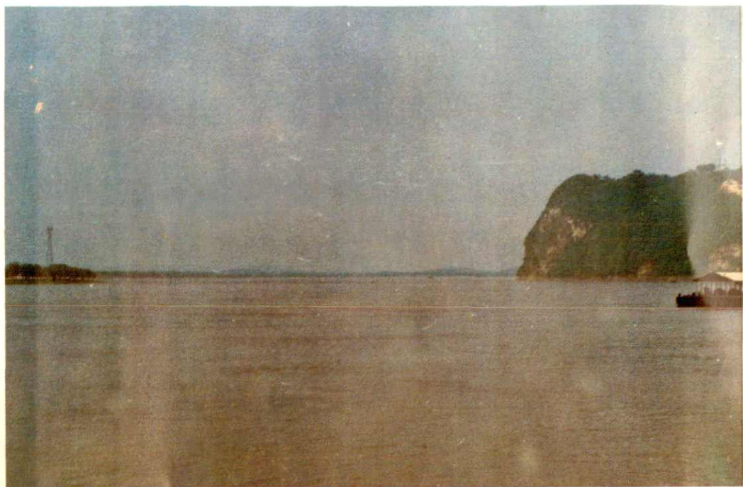
跨越长江天堑的 110 千伏白特线
