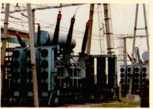
1 . 黄石地区枢纽变电站 —— 220 千伏新下陆变电站。 2 . 下变 220 千伏 1、2 号 15 万 千伏安主变压器。 3 . 黄石地区输电大动脉 —— 220 千伏风下 I、II 回线路。
