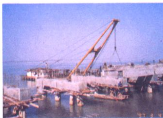
△正在建设中的龙门新港
