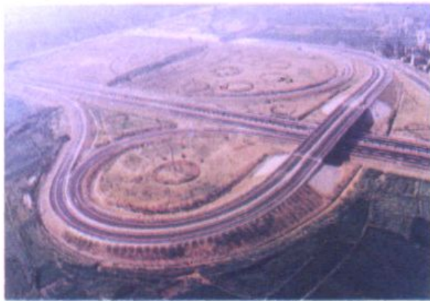
△高速公路镇江互通立交
