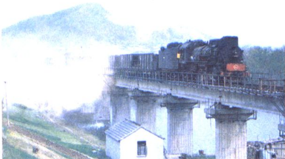
△满载货物的列车运行在运河特大桥上
