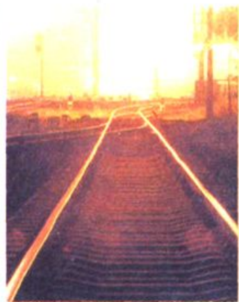
△镇大铁路接轨点
