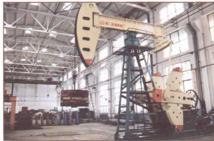
抽油机产品组装调试
