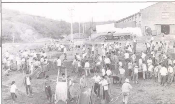
铆焊装配车间土方会战
