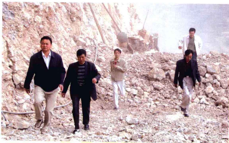
2008年4月21日，县政府副县长白长早检查沿江公路建设情况。
