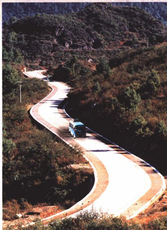
改建后的山区公路——三塘公路
