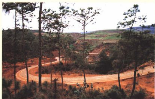
县交通局扶贫公路——矿马公路
