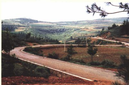
改建后的乡道——沙马公路
