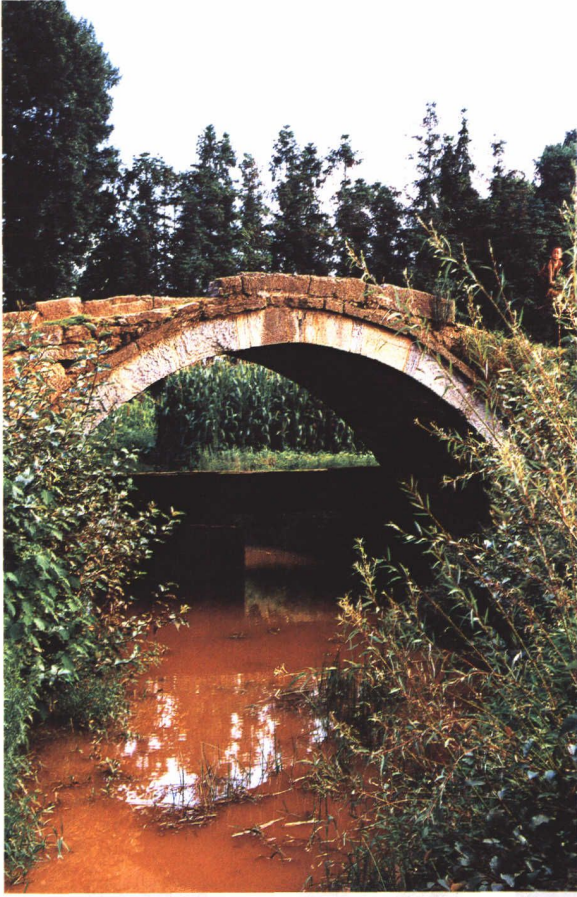
古桥梁——金马镇雨龙桥
