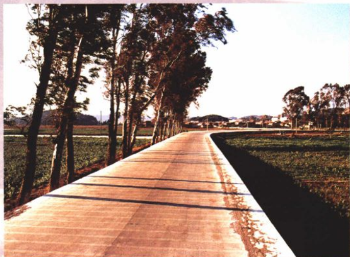
改建后的乡道——箐门公路 (县城~紫薇山段)
