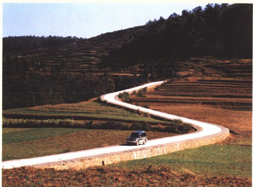
改建后的乡道 ——孔照堡公路
