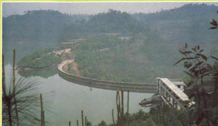
◀ 木桥沟(中型)水库
