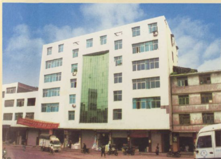
马安区畜牧站职工住宿楼和办公楼
