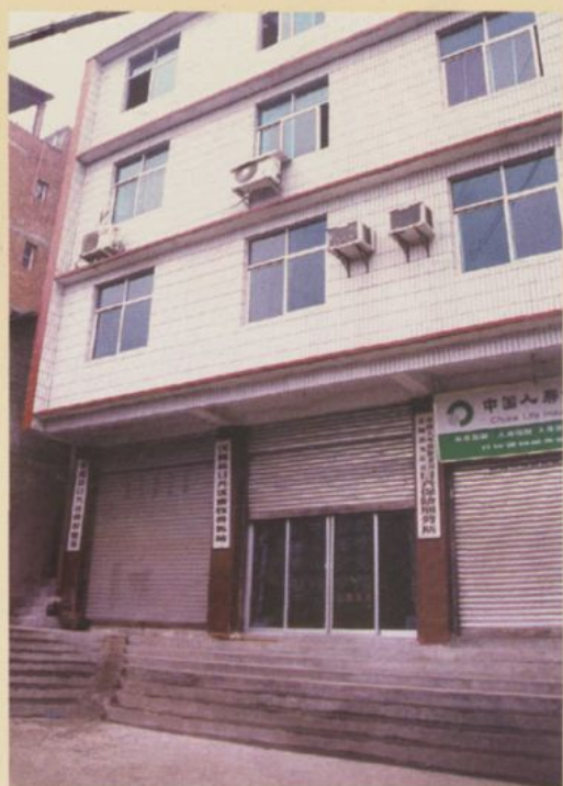
日兴区畜牧站办公楼
