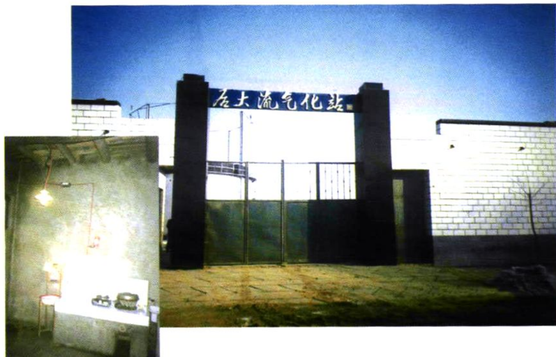
清丰县大流乡后大流村秸秆气化站及前大流村沼气示范
