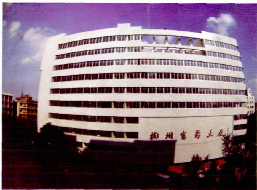
▲ 杭州市电影发行放映公司新建电影大厦 (刘浩源摄)
