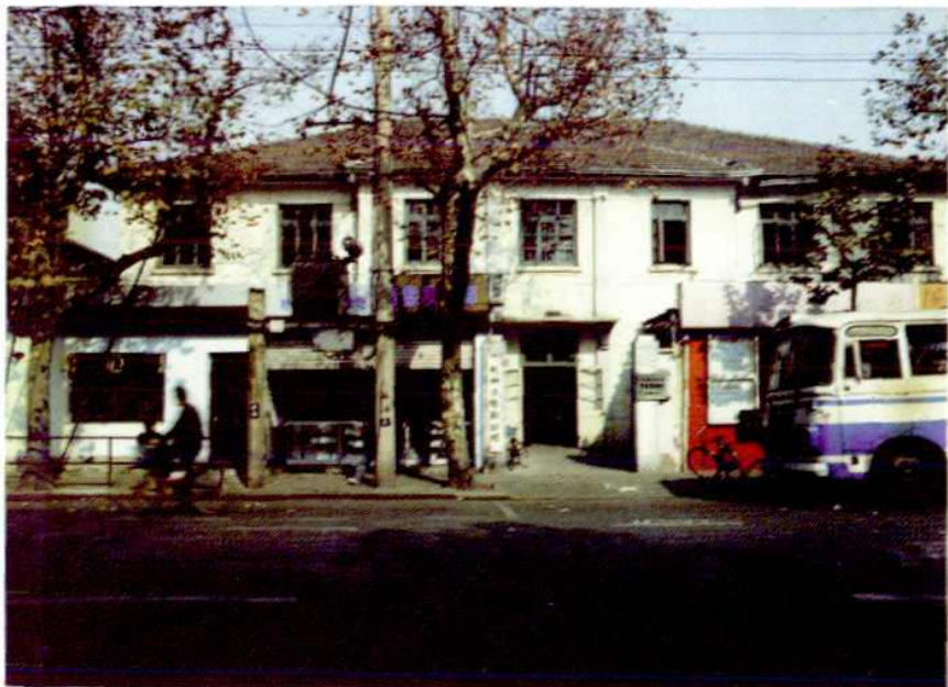
▲ 杭州市电影公司原办公楼
