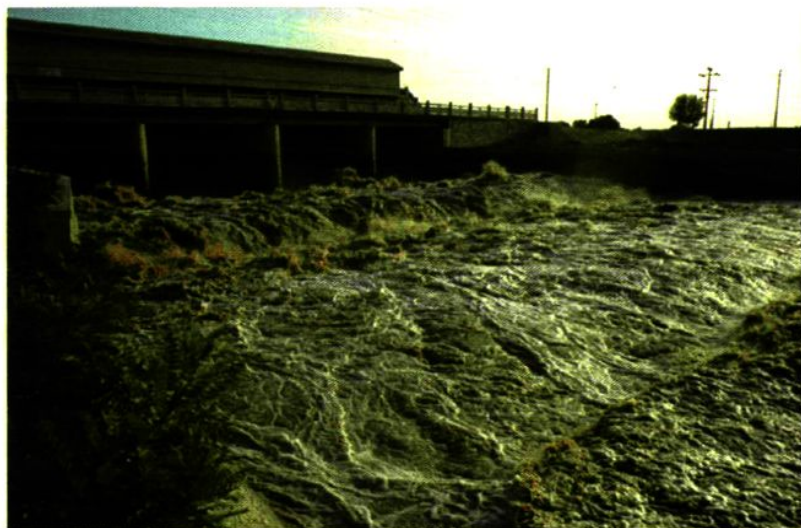
三盛公水电站跌水闸
