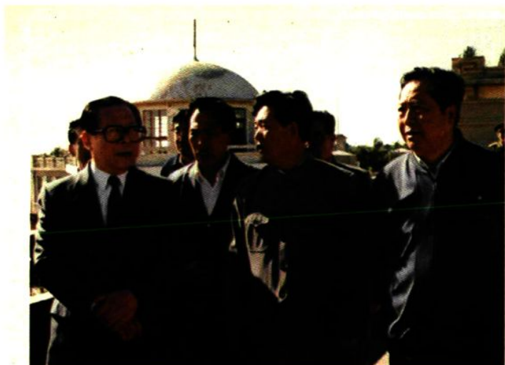
1990年9月,中共中央总书记、国家主席江泽民视察黄河三盛公水利枢纽工程
