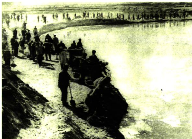
拦河闸截流工程施工现场
