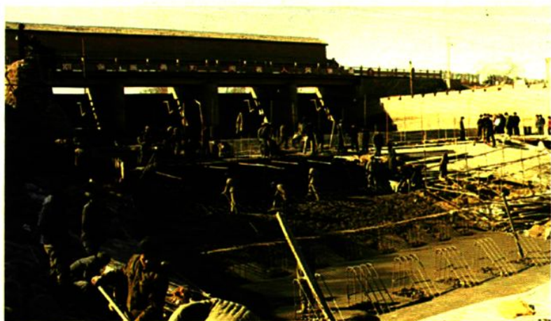
跌水闸消能防冲 加固工程施工现场
