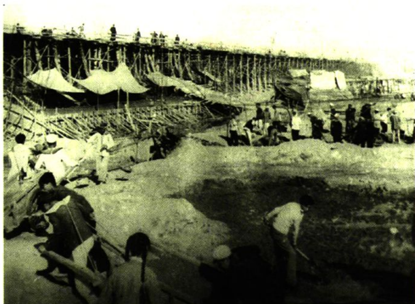
拦河闸闸底工程施工现场
