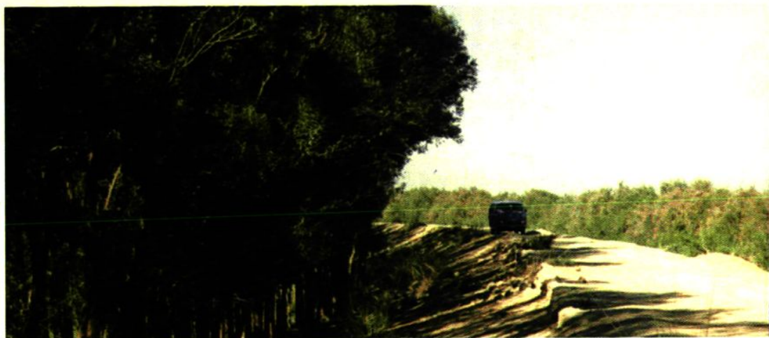
拦河闸上游防洪堤
