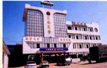
交警办公大楼
