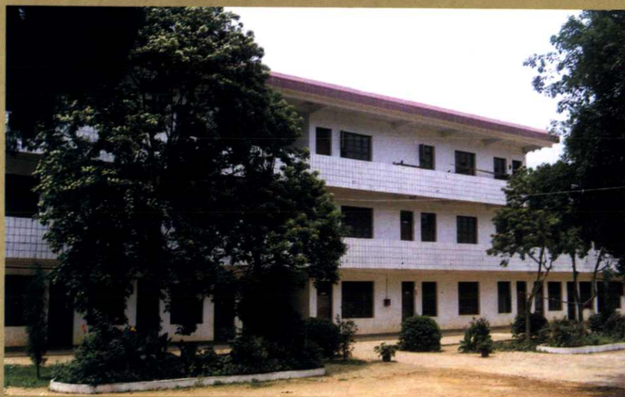
宽田中学综合楼
