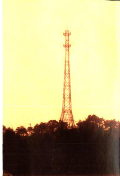
移动通信基站
