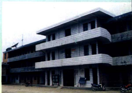
乡机关办公楼
