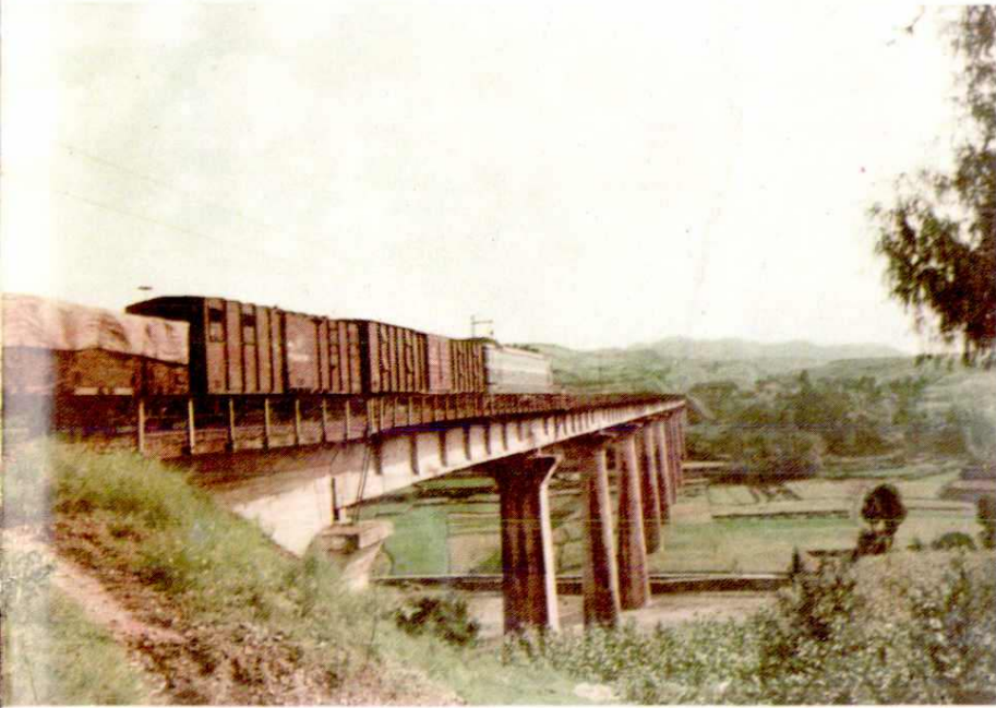
新铺湾铁路大桥
