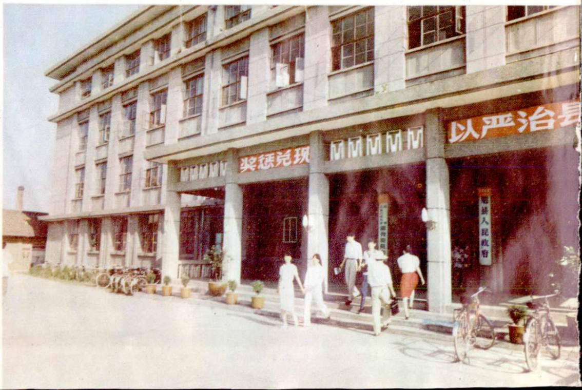
勉县人民政府大楼
