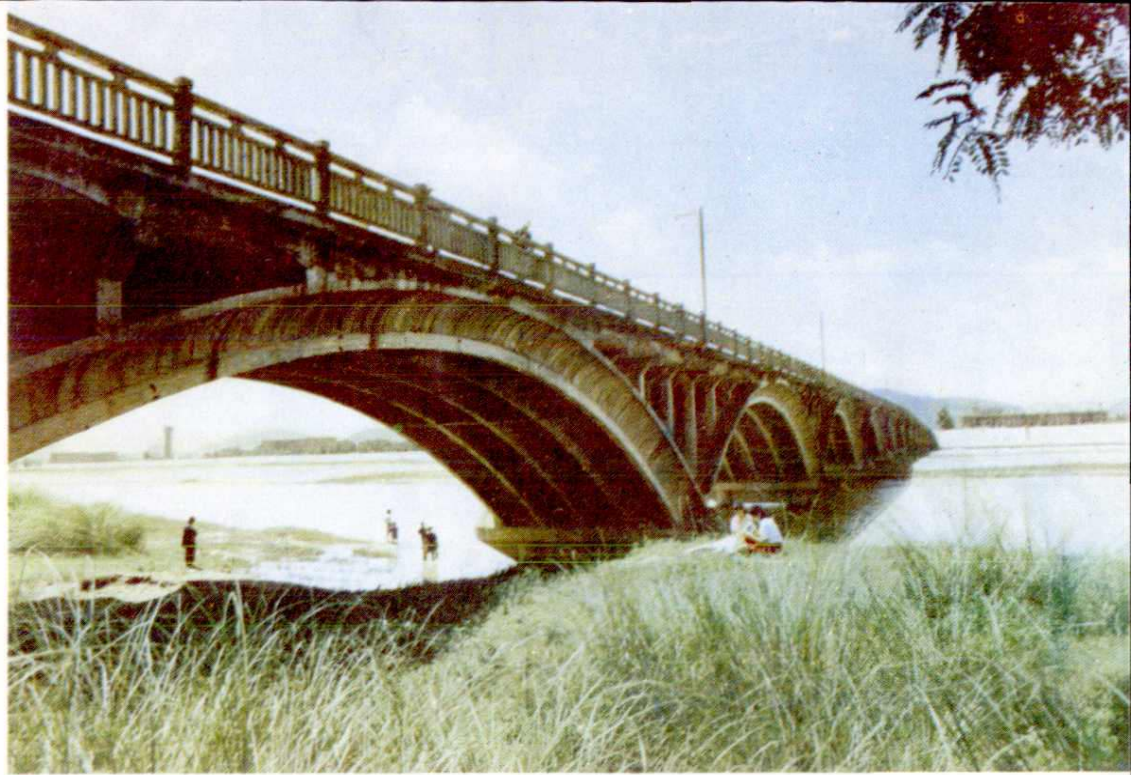
勉县汉江大桥
