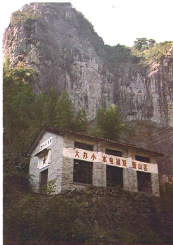
里家山水电站
