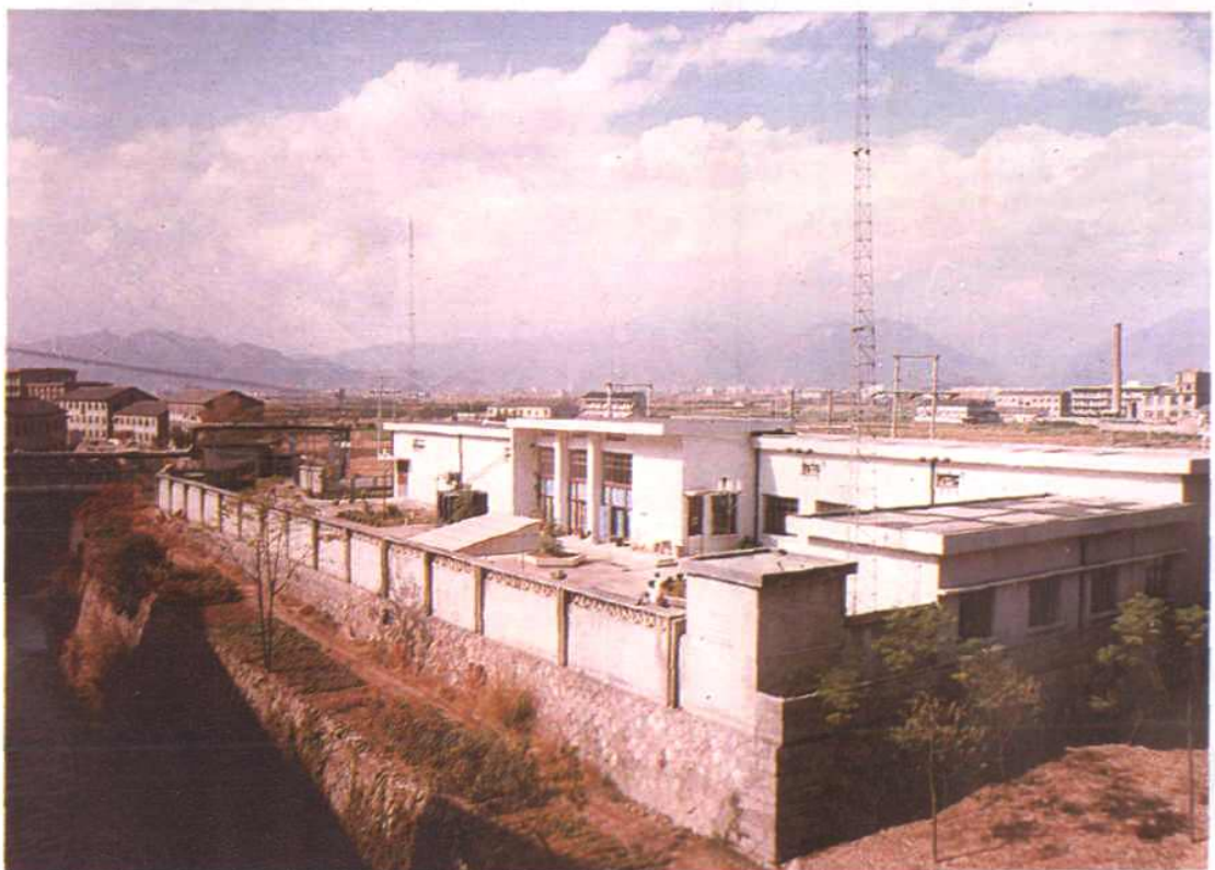
35 千伏河埠变电所
