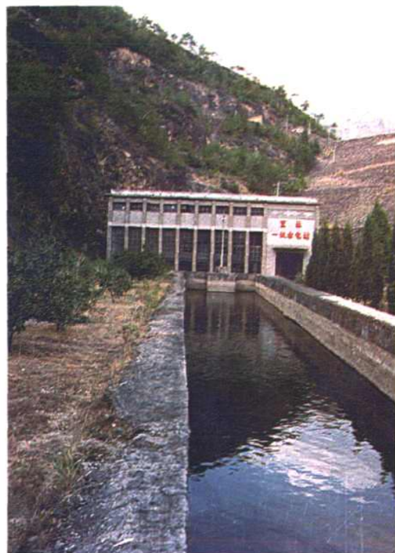
里林一级水电站
