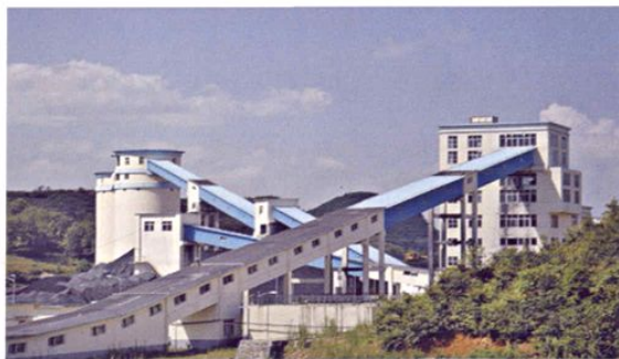
青龙煤矿原煤生产系统
