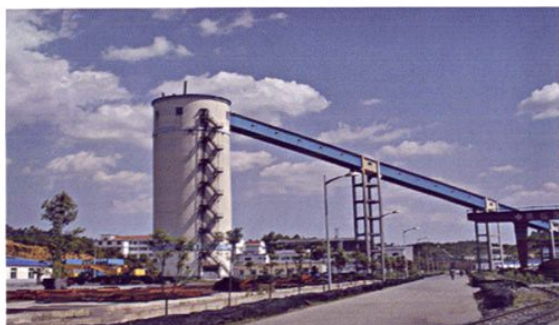
青龙煤矿运输系统皮带栈桥
