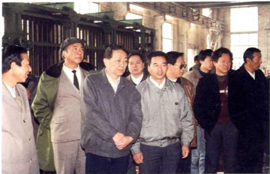
原中共中央政治局委员、市委书记谭绍文视察我区第一个大型技改项目双街钢管集团钢管热镀锌技术改造
