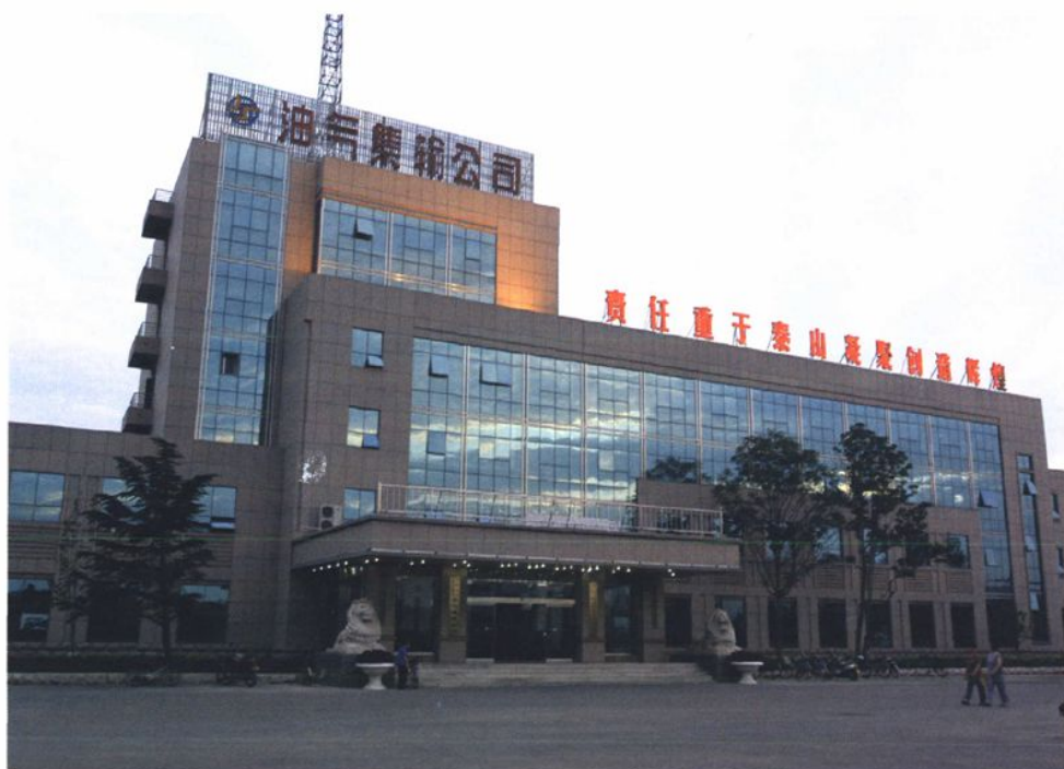
油气集输公司机关办公楼
