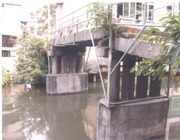
平地大桥（桥头石桥）
