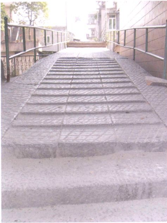
平地大桥（桥头石桥）
