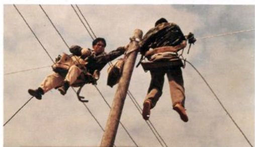
架设光缆线路
