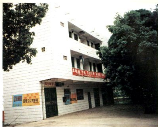
1998年建成的龙南邮电所
