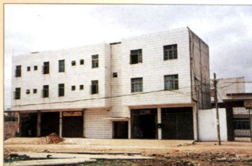
1996年建的五山邮电所
