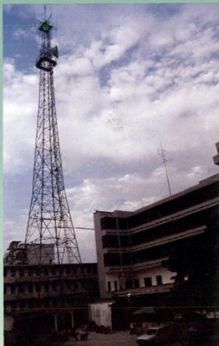
县局移动电话中心基站铁塔
