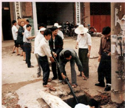
敷设地下电缆
