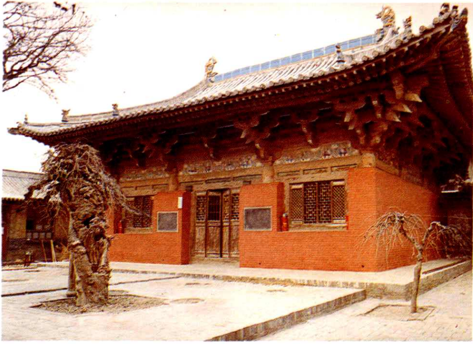
镇国寺万佛殿全景
