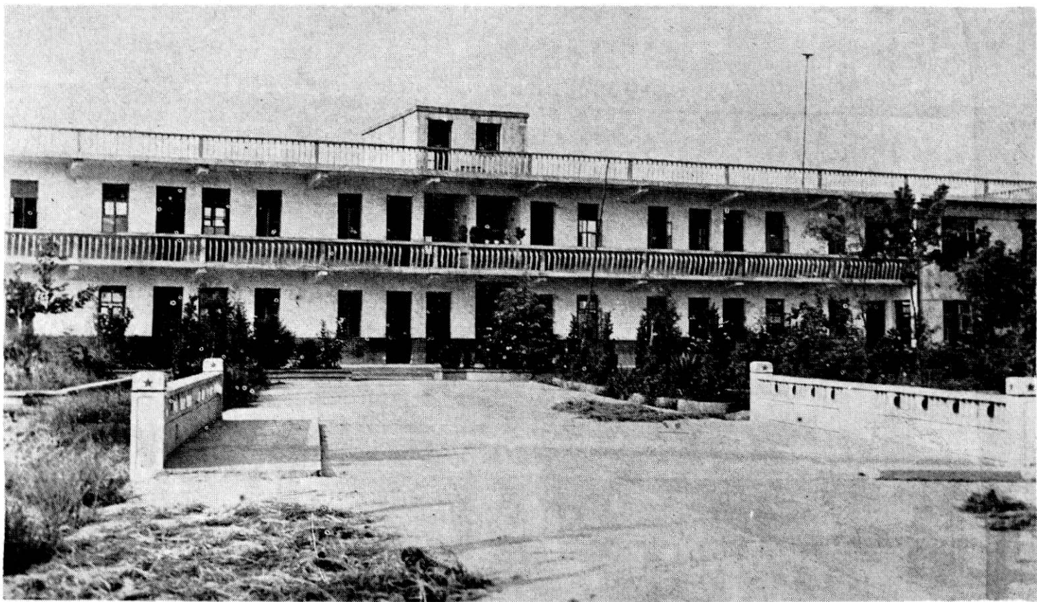
北港中心小学教学大楼
