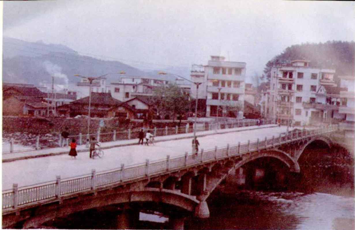
妙高镇叶坦大桥
