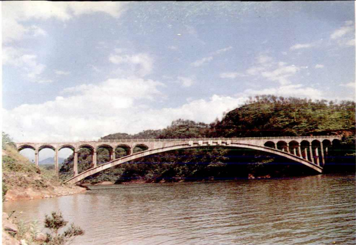
湖赤公路垅潭大桥
