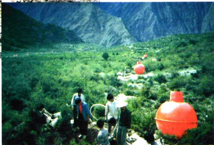
GFRP水窖——PEX水管 集水灌溉技术应用
