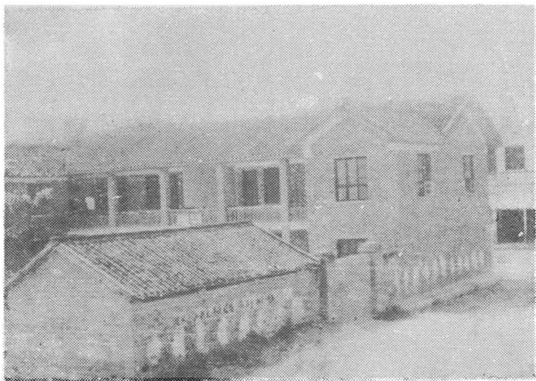
民主坑水电修防管理委员会办公楼
