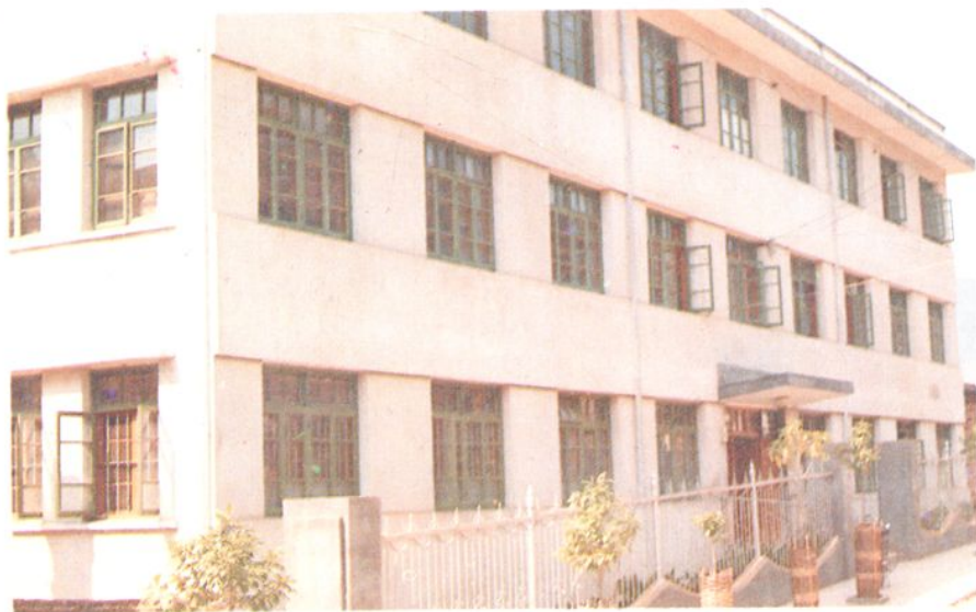
县防疫站办公楼
