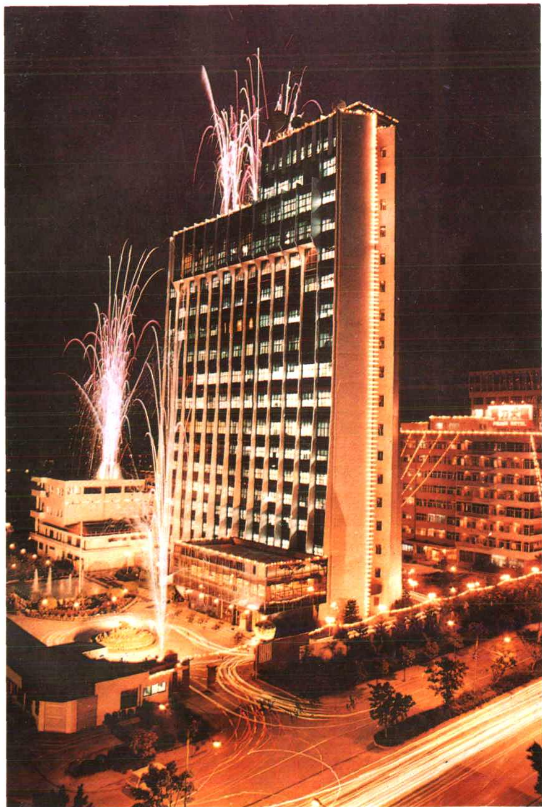
省电网调度大楼
