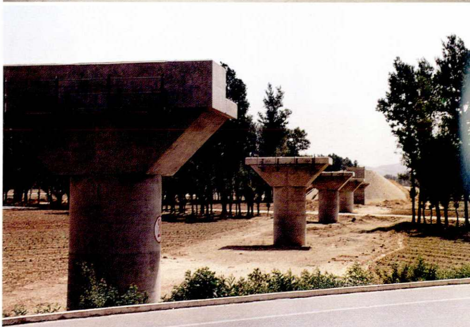
建设中的铁路路基
