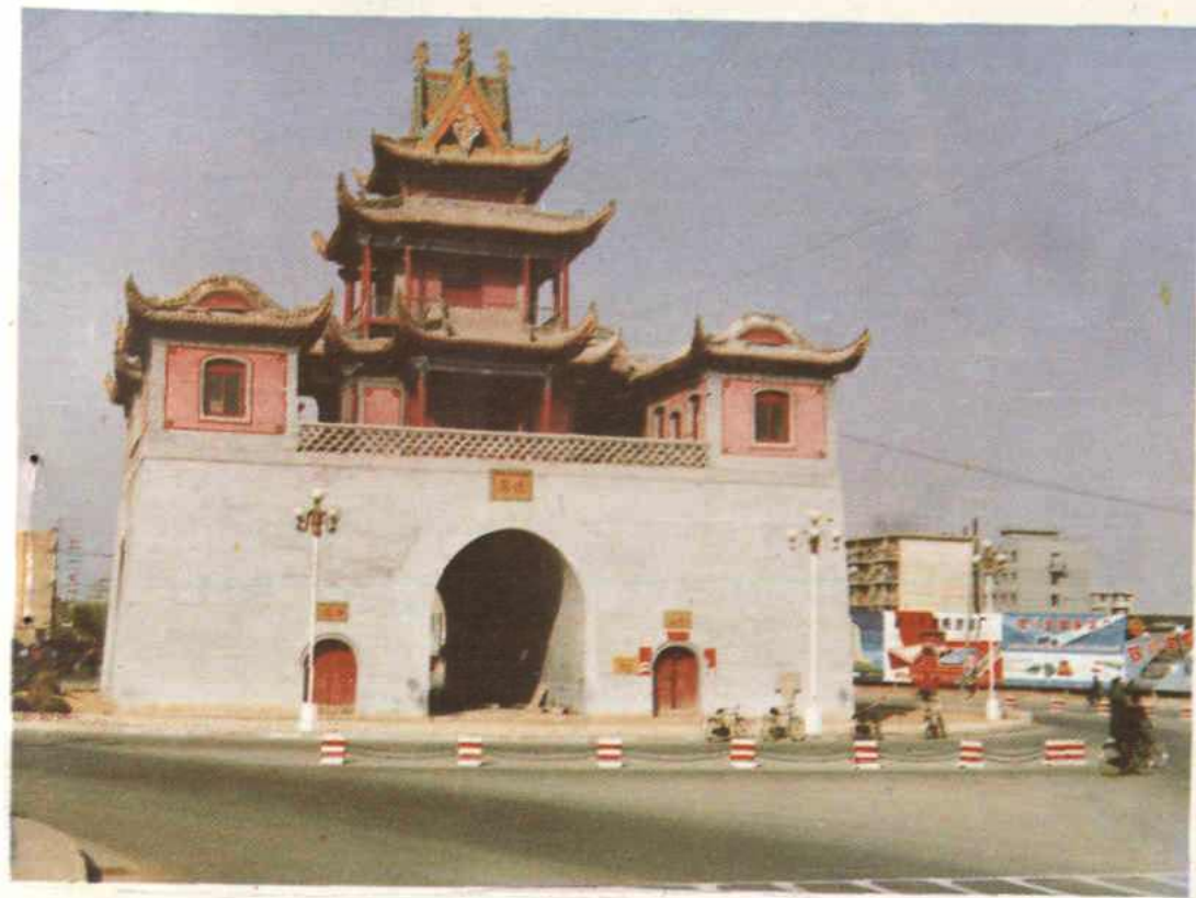
↙ 钟鼓楼 ↓ 南门楼
