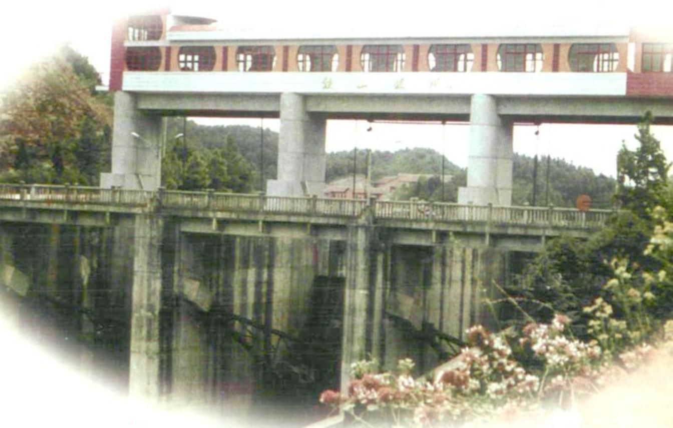
▲ 铁山水库溢洪道净宽 30 米,堰顶设  $10 \times 9.3$  米
