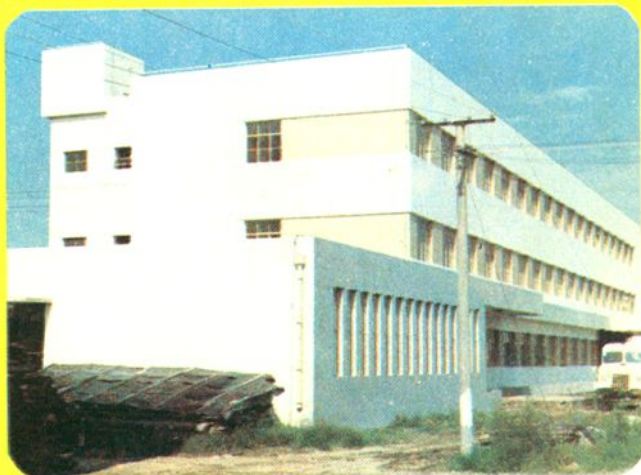
新建的周浦医院门诊医科大楼
