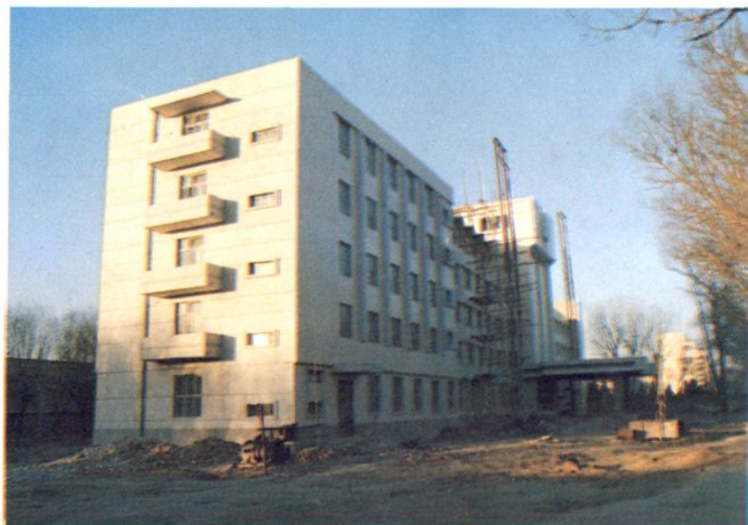
新建中的门诊楼
