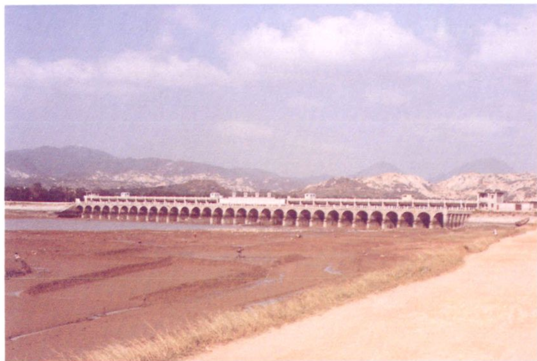
洛阳桥(公路桥)
