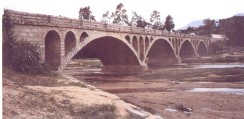
赤土桥(乡村道路桥)
