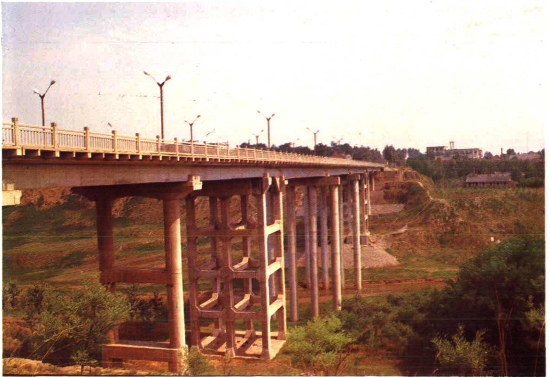
三原临履公路大桥
