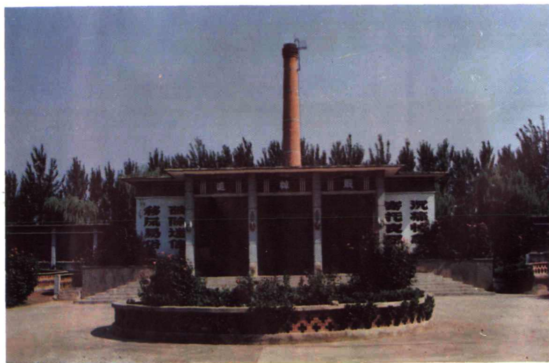
三原县火葬场追悼厅
