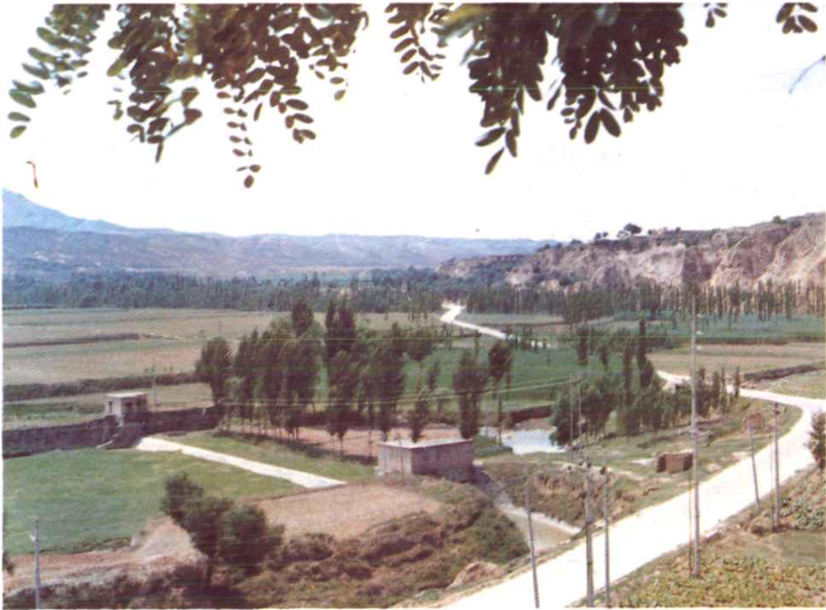
清惠渠滚水坝闸门
