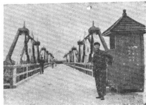
钢木桁架桥(即红旗桥)
