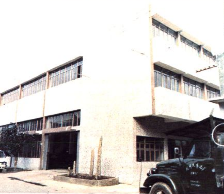
杭州叉车厂塘栖分厂金工车间
