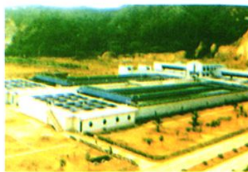
珠海西区水厂
