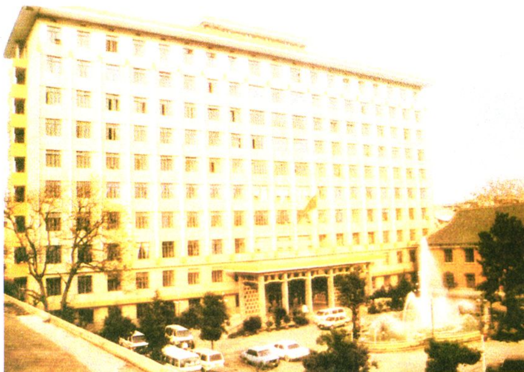
长沙市政府办公楼
