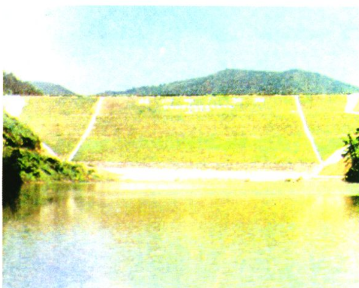
株洲电厂灰坝
