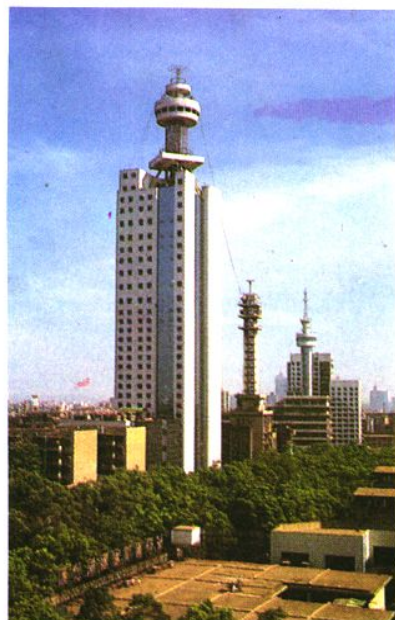
湖南省电力调度大楼
