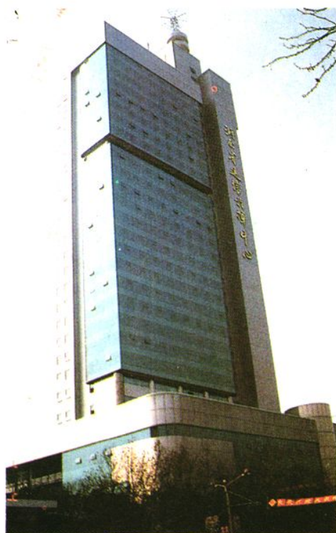
湖南省通信指挥中心 ——中建总公司优质工程银奖
