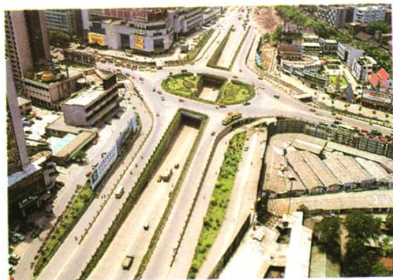
长沙芙蓉路立交桥
