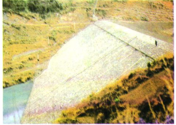
湖南冷水江锡矿山尾矿库大坝
